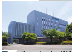
3 マツダR&Dセンター横浜 所在地：日本 神奈川県横浜市
