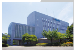
3 マツダR&Dセンター横浜 所在地:日本 神奈川県横浜市
